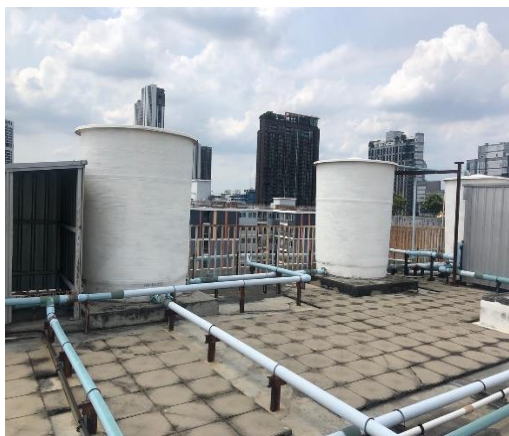
ภาพที่ 10 ถังเก็บน้ำสำรองอาคาร
