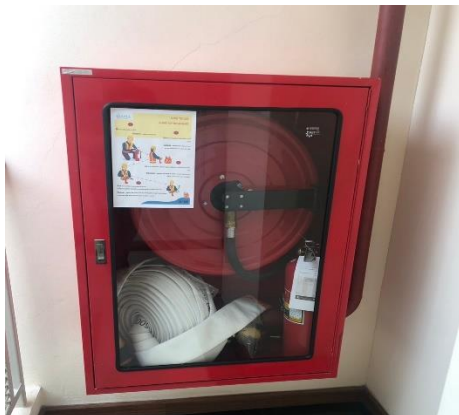
ภาพที่ 22 ตู้สายฉีดน้ำดับเพลิง
