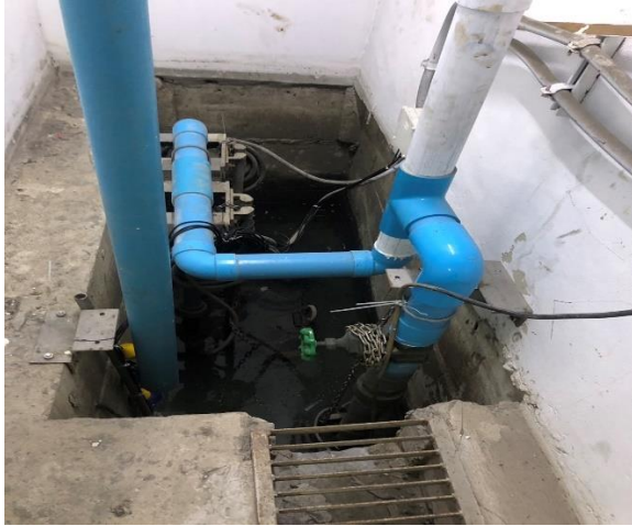
ภาพที่ 23 น้ำสำรองสำหรับดับเพลิง
